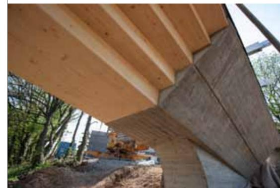
Am Holzüberbau verschraubte Stahlwinkel übertragen im Endzustand die Schubkräfte und bilden die Auflager im Bauzustand. Die Fuge zwischen Stirnholz und Stahlbetonfundament wird nach dem Einbetonieren der Gewindestangen mit schwindarmem Vergussmörtel vollflächig gefüllt.
