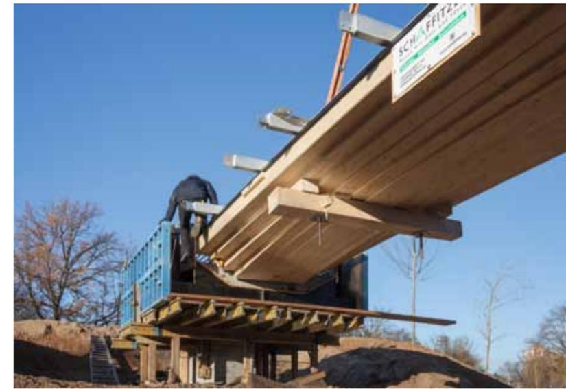
Die Brücke in Weinstadt besitzt die kürzeste Spannweite der drei neuen Bauwerke im Remstal. Der Überbau wurde hier als flaches Bogentragwerk ausgebildet.
