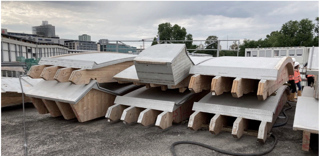
Abb. 64: HKT-Elemente (Schalungen der seitlichen Bahnhofswand) auf der Baustelle in Stuttgart, 2022, Foto: Stefan Krötsch
