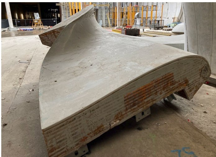
Abb. 18: links: Element U_8_C - „Hutzenschalung“; Foto: Stefan Krötsch; rechts: Entwurf zur Verwendung der „Hutzenschalung“, Stuttgart 210
