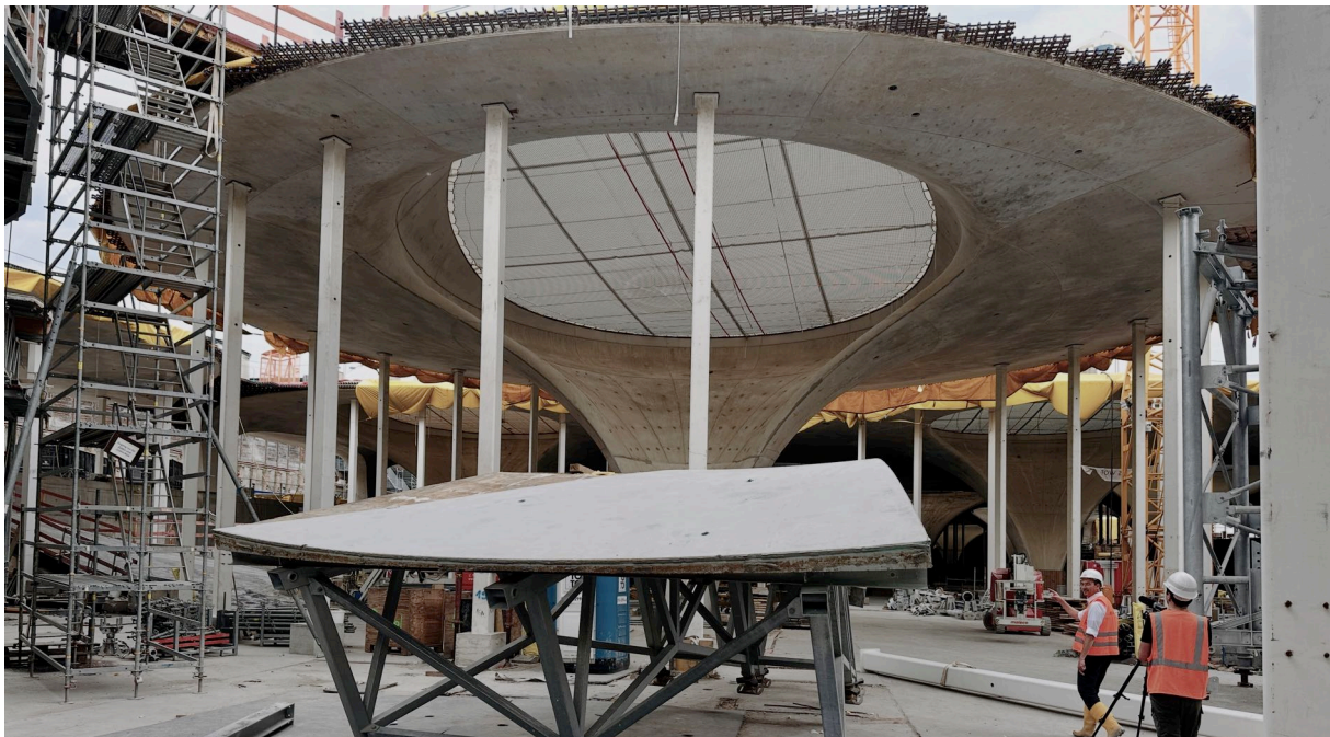
Abb. 1: Schalungselement und bereits betonierte Kelchstützen auf der Baustelle des Stuttgarter Hauptbahnhofs; Foto: Roman Kreuzer
