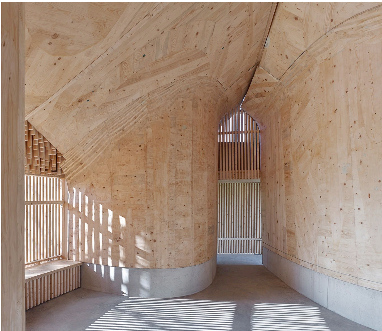
Abb. 83: Innenraum: Die Holzoberfläche dokumentiert durch die abgefassten Brettsperrholzlagen den dreidimensionalen Bearbeitungsprozess des Roboterarms, Foto: Achim Birnbaum
