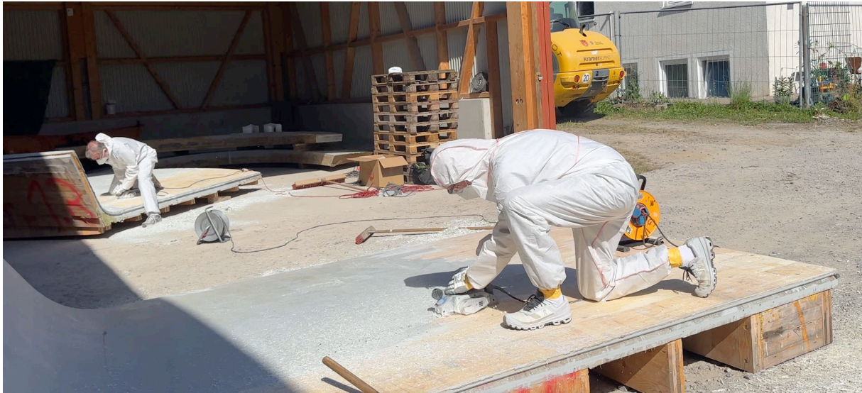
Abb. 35: Abfräsen der Beschichtung bei der Vorbereitung des Reallabors Ingersheim, Foto: Roman Kreuzer
