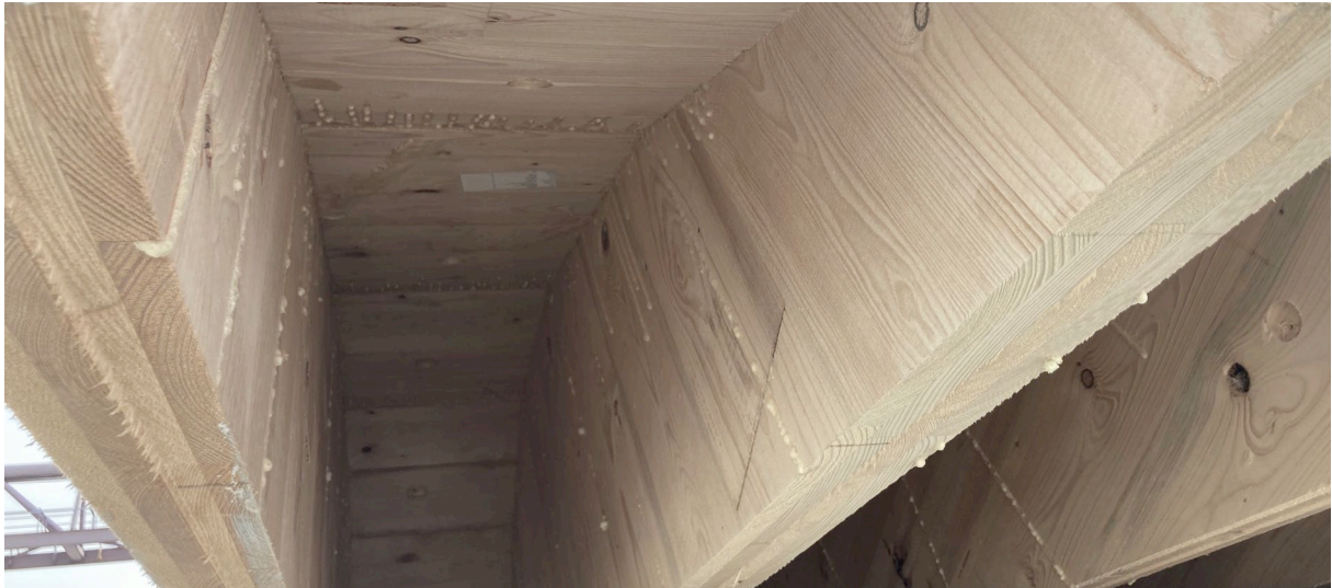
Abb. 11: Rippenstruktur auf der Rückseite stark gekrümmter Elemente; Foto: Stefan Krötsch
