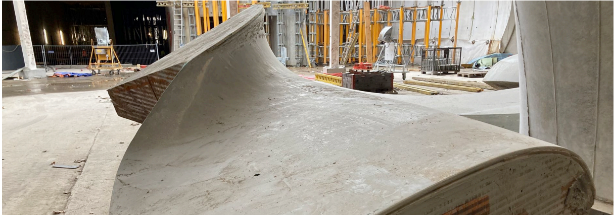
Abb. 90: „Hutzenschalung“ aus der Baustelle in Stuttgart, Foto: Stefan Krötsch
