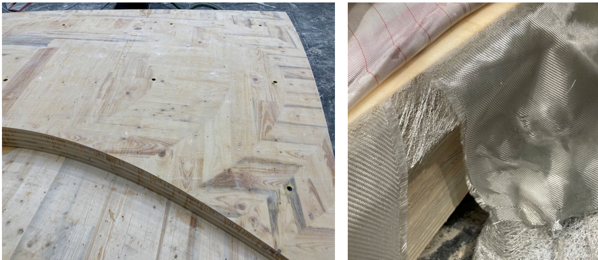
Abb. 15: links: Grundierung der Schaloberfläche, rechts: Zweilagige Glasfaserarmierung und Beschichtung unter temporärer Abdeckung (weisses Tuch mit roten Streifen); Foto: Stefan Krötsch
