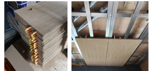
Das Deckenheiz- beziehungsweise Kühlsystem hinter Lehmputzplatten schafft eine komfortables Raumklima
