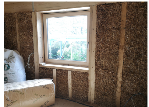
Alle sechs Fassaden – also auch das Dach und die Geschosßdecke nach unten – sind in ökologischer Strohballenbauweise ausgeführt
