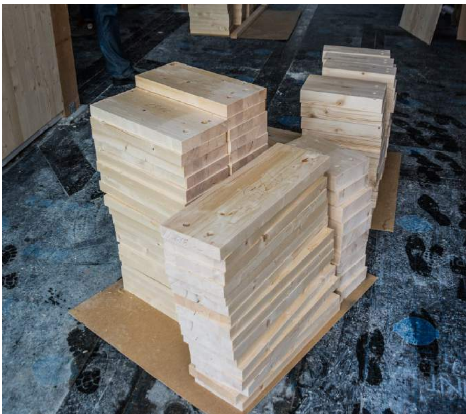
Abbildung 5 "Schlitzbleche" aus Holz zur Verbindung der Stützen und Decken über zwei Geschosse hinweg, 2
