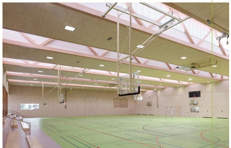
Die Sheddach-artigen Doppelfachwerke erhielten eine seitliche Bekleidung aus lichtstreuenden Polycarbonatstegplatten. Das ermöglicht eine gleichmäßige und blendfreie Belichtung der Halle mit Tageslicht. In den Oberlichtbändern sind zudem Lüftungskappen zur natürlichen Belüftung und Entrauchung der Halle eingebaut.
