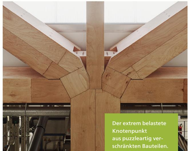
Der extrem belastete Knotenpunkt aus puzzelartig verschränkten Bauteilen.
