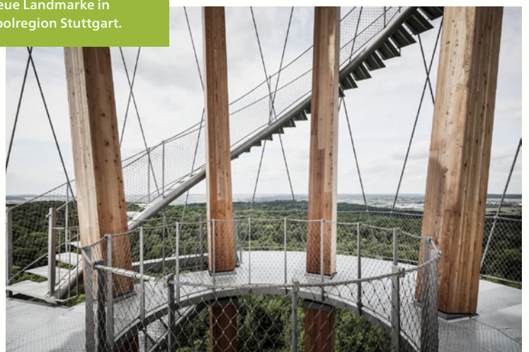
Um die Verbindung von Bauwerk und Region zu verstärken, entschied man sich für die Verwendung von Brettschichtholz, das von Lärchen aus dem Schönbuch stammt.
