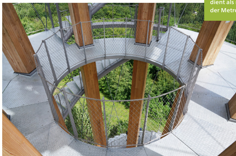
Um die Verbindung von Bauwerk und Region zu verstärken, entschied man sich für die Verwendung von Brettschichtholz, das von Lärchen aus dem Schönbuch stammt.
