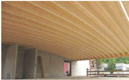
Neubau der Feuerwache Plochingen
