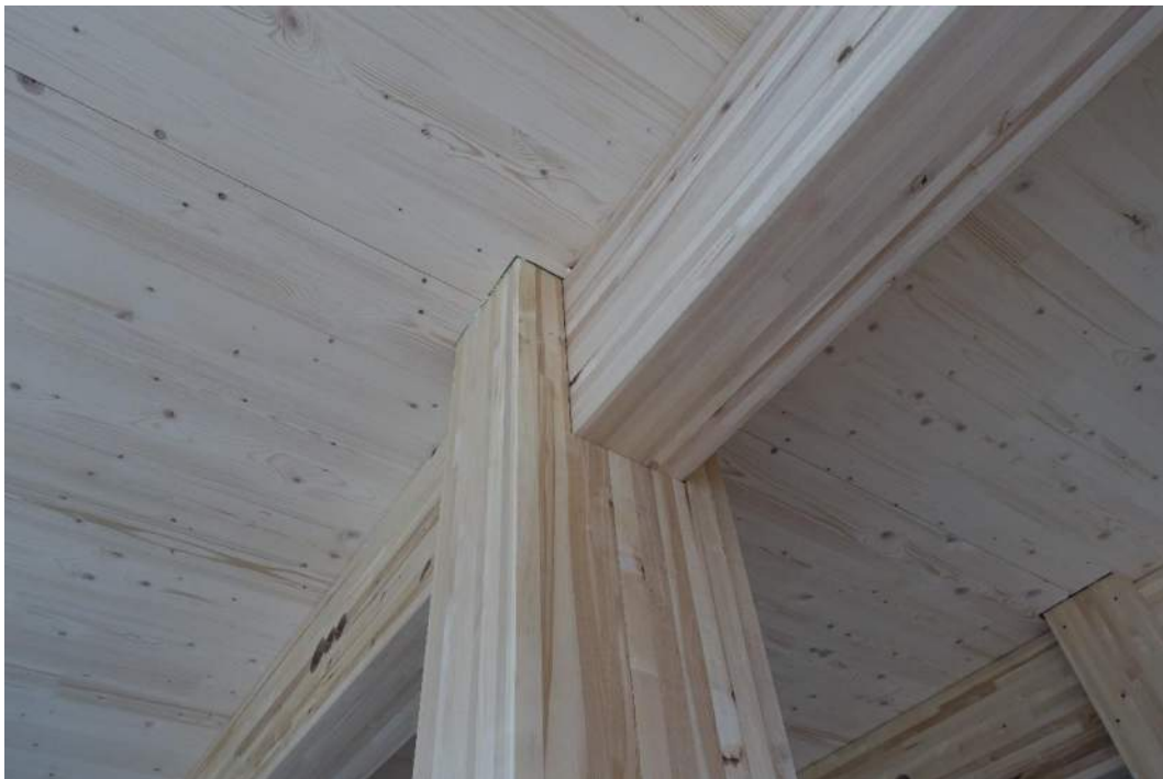
Abbildung 20: Gabelstütze (Neubau Kreisverwaltung Ingelheim, TWP: Fast+Epp)
