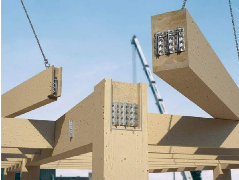
Abbildung 22: Balkenträger als Balken-Stützen-Verbindung [52]
