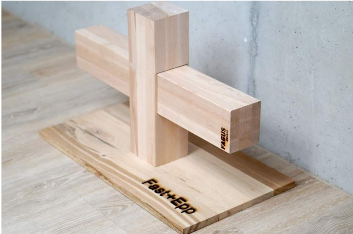
Abbildung 75: Modell des Stützenknotens Konzept 1
