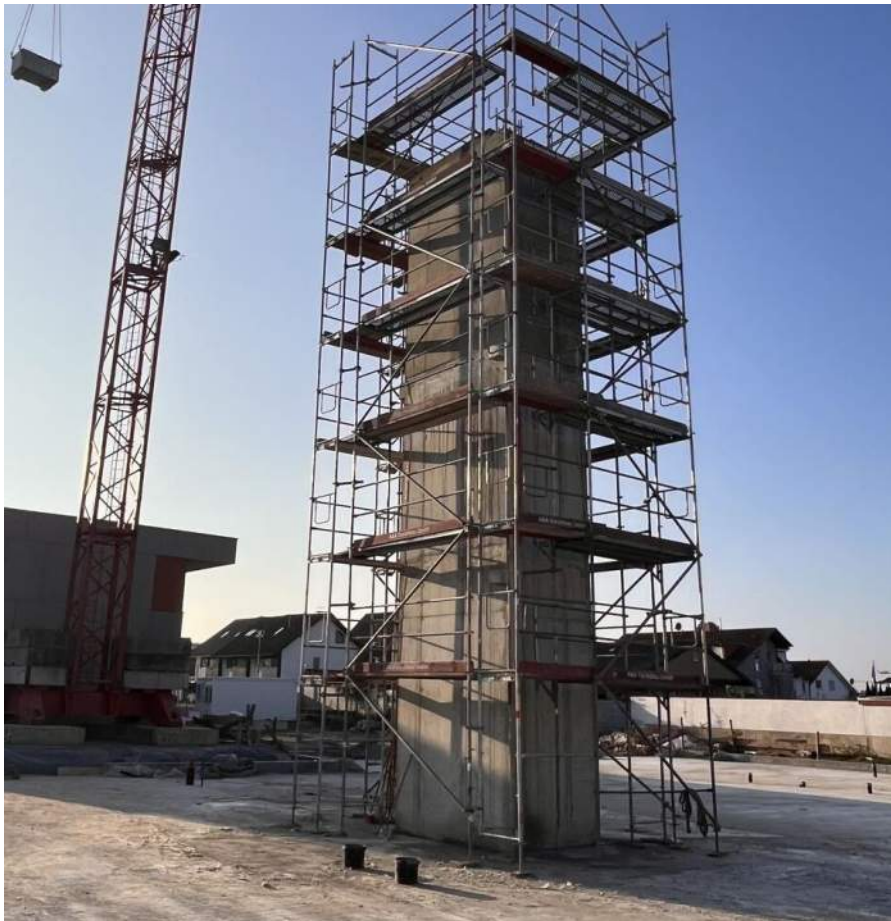
Abbildung 29: Freistehender Stahlbetonkern (Astrid-Lindgren-Schule Weiterstadt, TWP: Fast+Epp)
