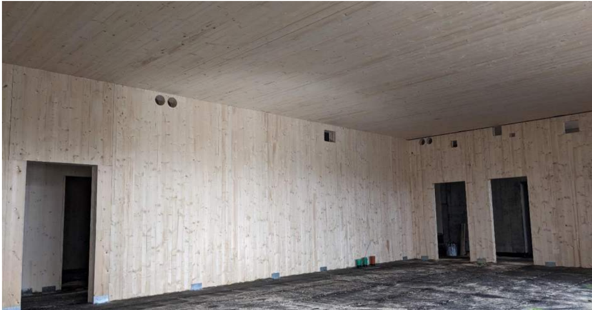
Abbildung 30: Brettspertholz-Wandscheiben beim Neubau Grundschule Raunheim, TWP: Fast+Epp
