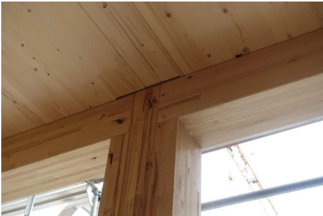
Abbildung 21: Ausgeklinte Stütze (Neubau Kreisverwaltung Ingelheim, TWP: Fast+Epp)
